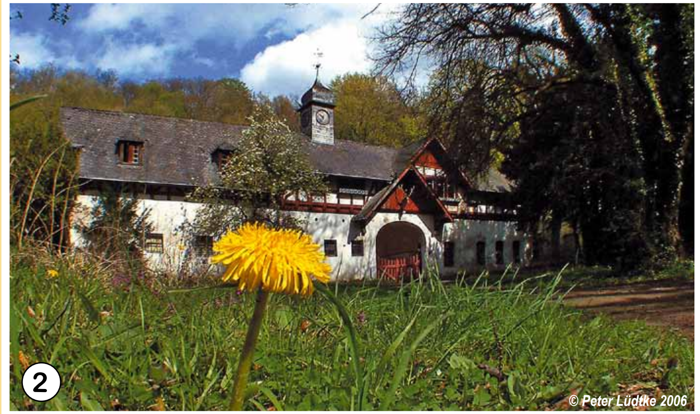
Gebäude der ehemaligen Filmunion in der Calmuth
