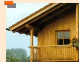
Große Dachüberstände sind regionaluntypisch
