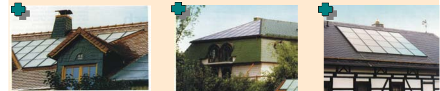
Beispiel für die vertretbare Integration von Sonnenkollektoren in Dachflächen
