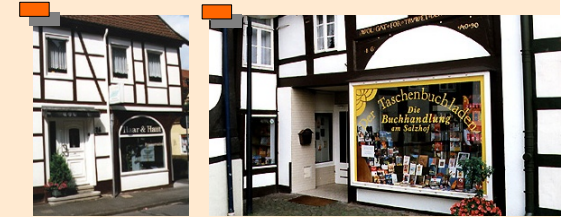
Die Gestaltung und Gliederung fügt sich nicht in das Fachwerkraster ein, das Obergeschoss des Gebäudes hat keinen konstruktiven Bezug zum Erdgeschoss
