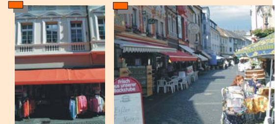
Durchlaufende Markisen verschleiern die Gliederung der Fassade und tragen dazu bei, dass die Obergeschosszone keinen konstruktiven Bezug zur Erdgeschoßzone hat.
