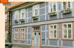
Verlust der Rahmenwirkung des Holzes
