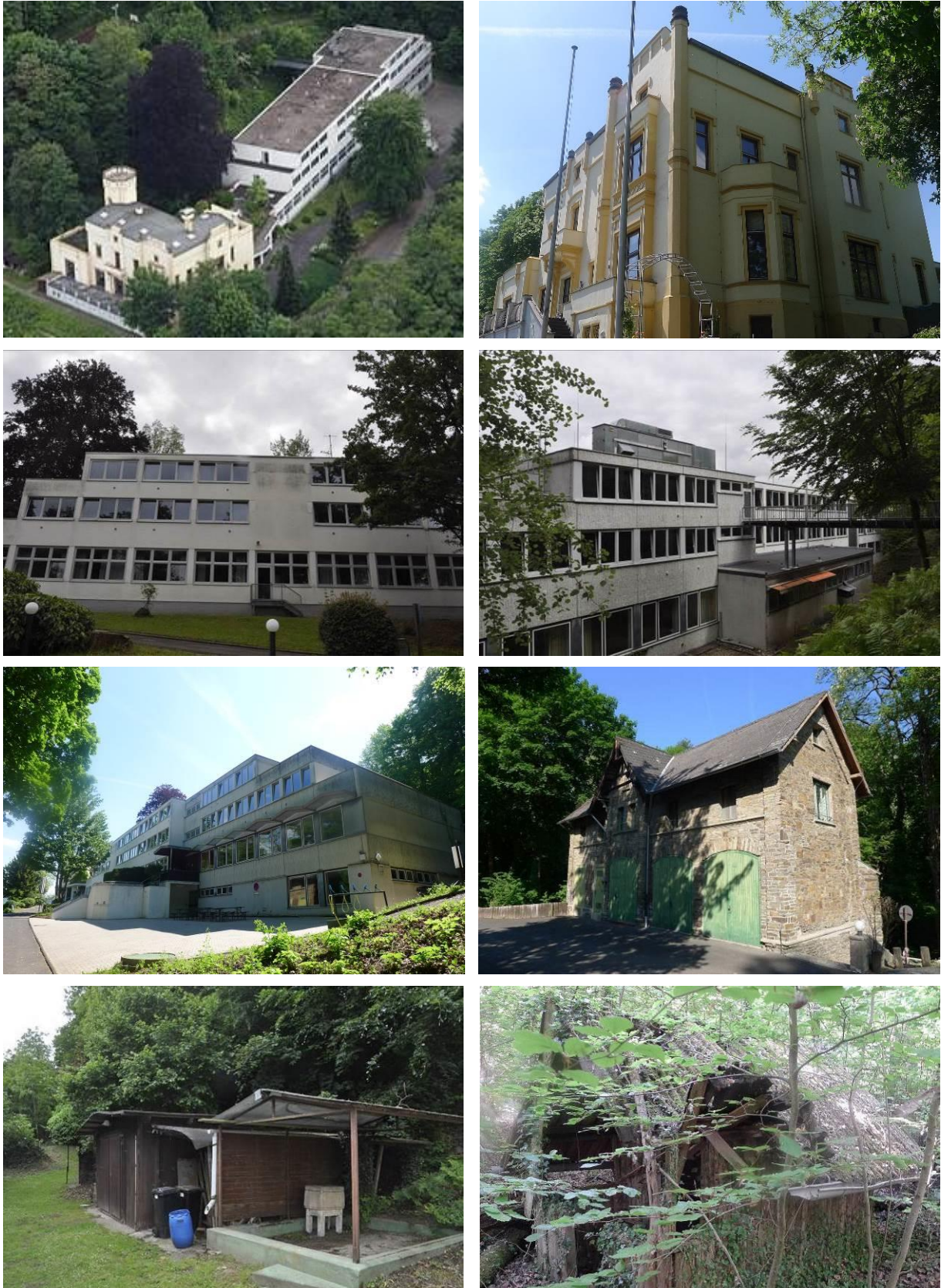
Abbildung 3: Gebäudebestand innerhalb des Planungsgebietes (Überblick und denkmalgeschütztes Haus [1. Zeile]; Anbau eines Seminargebäudekomplexes in den 1970er Jahren [2. Zeile u. 3. Zeile-links]; Trafoshaus aus Naturstein [3. Zeile-rechts]; Gartenschuppen, tlw. zusammengebrochen [4. Zeile])
