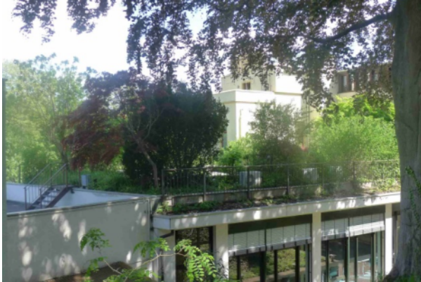
Abbildung 12: Verbindungsbau mit Dachgarten
