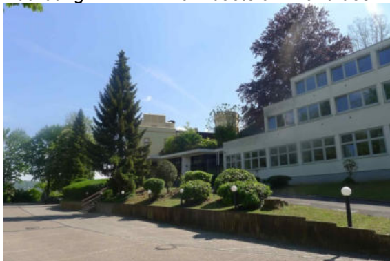
Abbildung 17: Pflanzbeete am Rand des Parkplatzes
