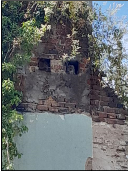
Abbildung 14: Ruhestätte Waldkauz, Nische im Turm, Nordostfassade
