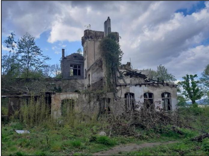
**Abbildung 8: Ansicht Südostfassade, Schiefer, offenes Mauerwerk, eingestürzte Dachbereiche**
