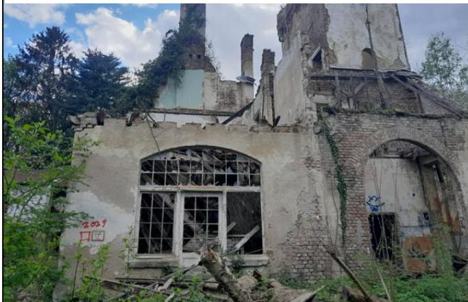
**Abbildung 9: Nordostfassade, Nischen, freie Zugänge, Spalten Mauerwerk**
