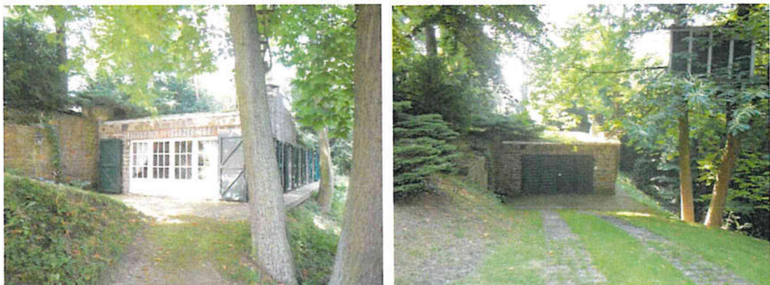
Vorhandenes Nebengebäude: soll zum Atelier umgebaut werden
