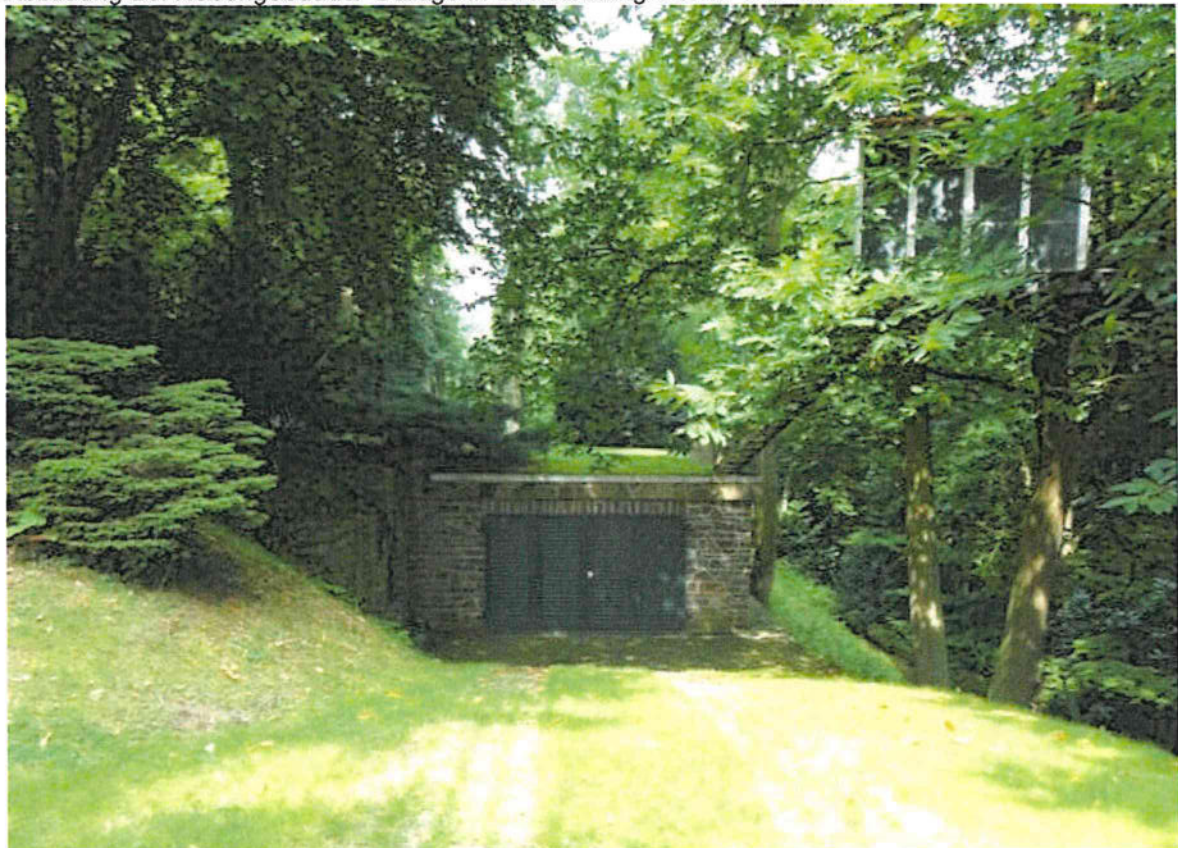
Abbildung 20: Nebengebäude/ Garage in Blickrichtung Osten → Westen
