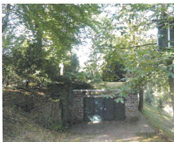
Abb. 15: Blick auf das übererdete Nebengebäude/ Garage in Blickrichtung Osten → Westen
