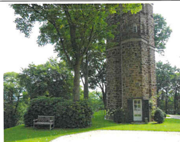
Abb. 18: Humboldturm in Blickrichtung Südwesten → Nordosten
