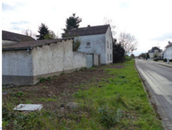
Standort: Westen; Blickrichtung: Südost (links im Bild: aufgegebene Hofstelle; rechts im Bild: Straße „Am Römerhof“)
