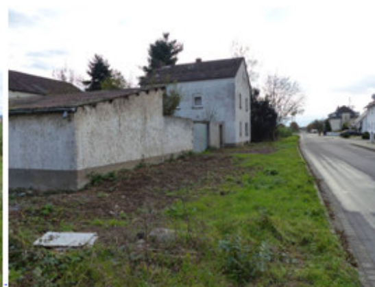
Standort: Westen; Blickrichtung: Südost (links im Bild: aufgegebene Hofstelle; rechts im Bild: Straße „Am Römerhof“)
