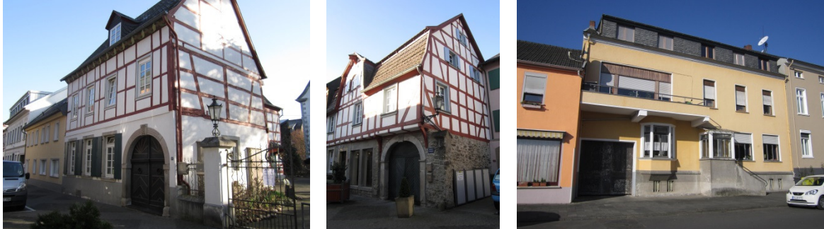
Abbildung 4: Zweigeschossige Gebäude an der Hauptstraße
